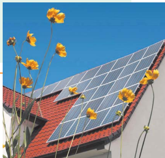
Casă cu baterii solare
